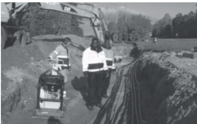
Mussa och Saidi tittar på rörläggningsarbeten på Gotland.
